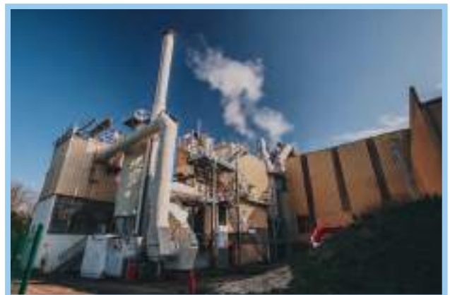
Une Unité de Valorisation Énergétique (UVE)
